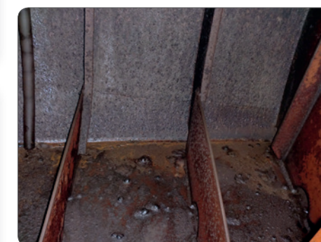
Formazione molto intensa di microrganismi nel serbatoio di gasolio
